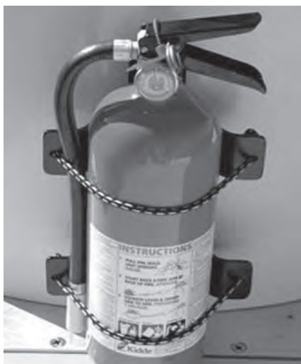
کپسول اطفای حریق مهار شده
